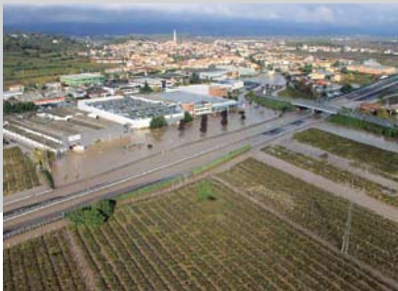
MONTEFORTE D'ALPONE, A SINISTRA, E SOAVE, A DESTRA, NEI GIORNI DELL'ALLUVIONE.
